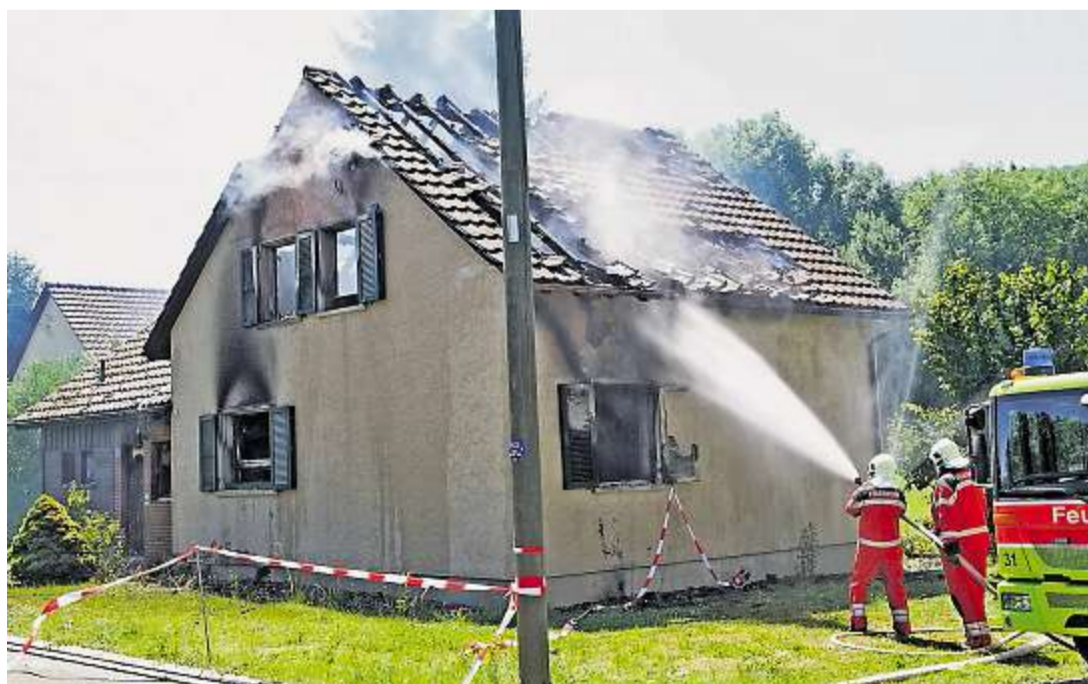
Die Feuerwehr konnte den grossen Sachschaden trotz schnellem Eingreifen nicht verhindern.
